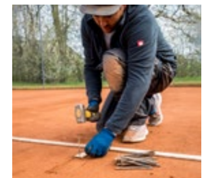
6. Die Markierungslinien werden vermessen und verlegt.
