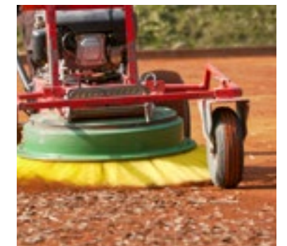
2. Die alte Gleitschicht wird entfernt.
