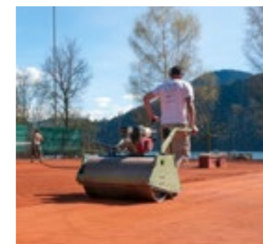
5. Es wird zweimal eingesandet und zweimal eingewalzt, für eine langanhaltende Spielqualität.
