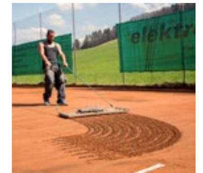
4. Verschleissstellen werden mit Belagsmaterial Vulkanit® aufgefüllt und angeglichen.
