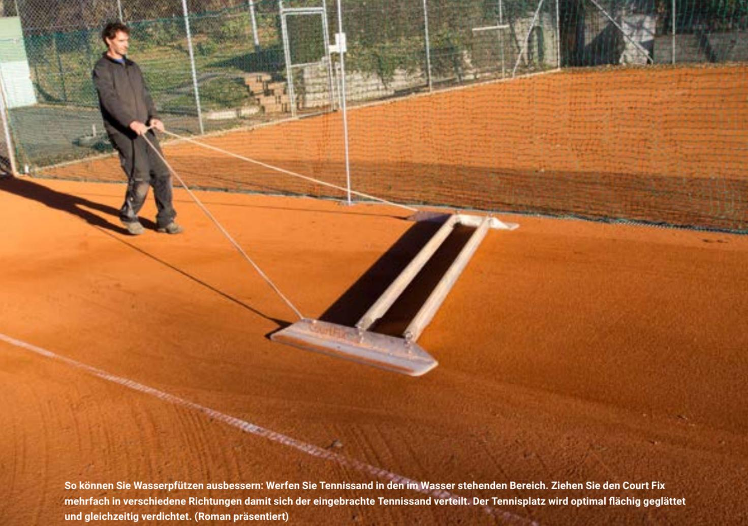
So können Sie Wasserpfützen ausbessern: Werfen Sie Tennissand in den im Wasser stehenden Bereich. Ziehen Sie den Court Fix mehrfach in verschiedene Richtungen damit sich der eingebrachte Tennissand verteilt. Der Tennisplatz wird optimal flächig geglättet und gleichzeitig verdichtet. (Roman präsentiert)
