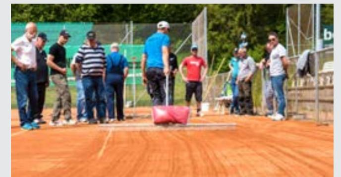
Randbereich nach Regen und Nachtbewässerung durch ziehen mit dem Stahldrahtbesen auflockern. Dabei kann der Besen mit einem Sandsack beschwert werden um mehr Druck zu erzeugen. Stahldrahtbesen finden Sie auf der Seite 20.
