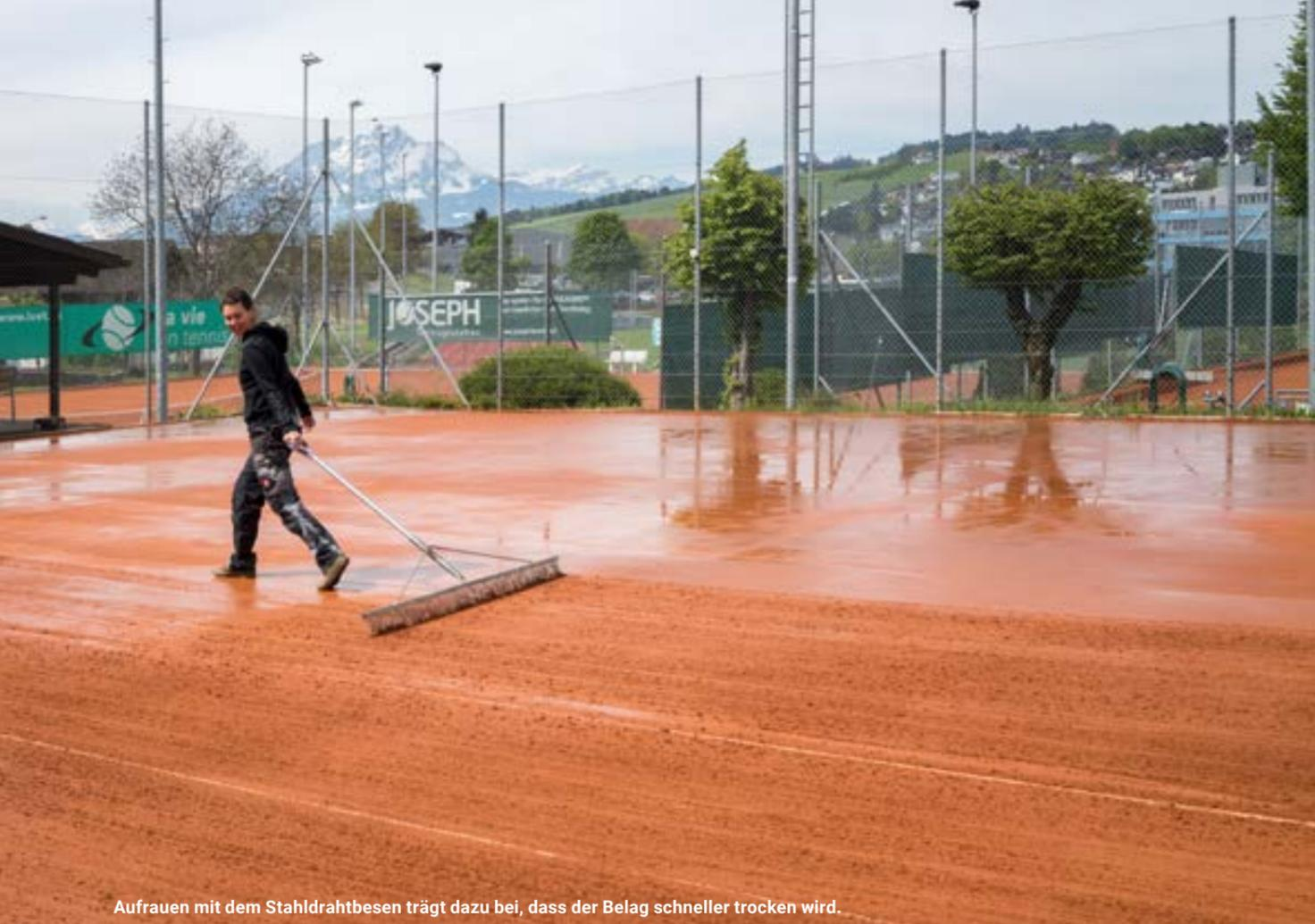
Aufrauen mit dem Stahldrahtbesen trägt dazu bei, dass der Belag schneller trocken wird.
