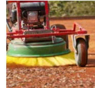
1. Die alte Gleitschicht wird entfernt.
