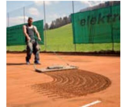
2. Verschleissstellen werden mit Belagsmaterial aufgefüllt und angeglichen.
