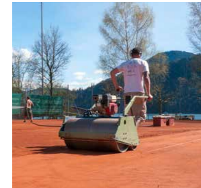
3. Es wird zweimal eingesandet und eingewalzt, für eine langanhaltende Spielqualität.
