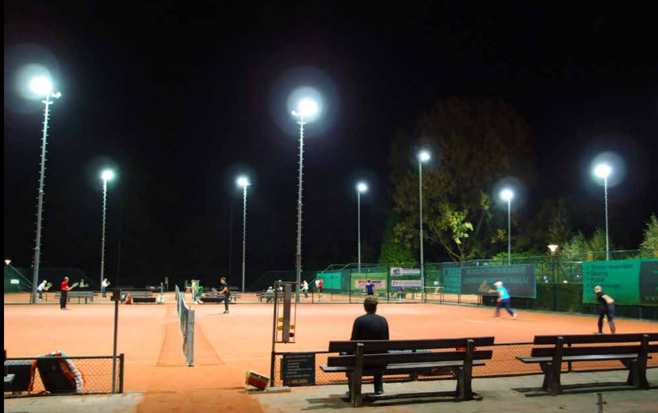
Wir sind Ihr Spezialist für die Planung und Ausführung von Beleuchtungsanlagen.
