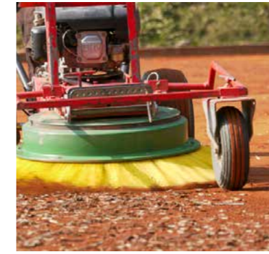
1. Die alte Gleitschicht wird entfernt.
