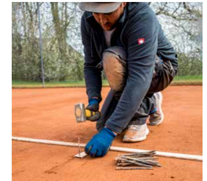
4. Die Markierungslinien werden vermessen und verlegt.
