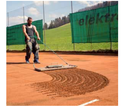
2. Verschleissstellen werden mit Belagsmaterial aufgefüllt und angeglichen.
